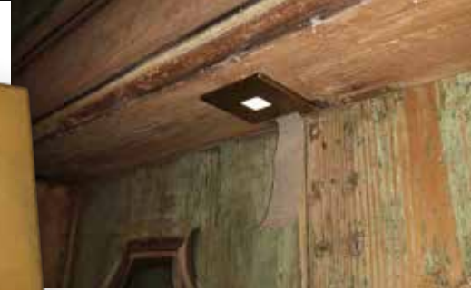
moderne Technik trifft UNESCO Weltkulturerbe – Spezialleuchten aus Messing im Markgräfischen Opernhaus in Bayreuth modern technology meets UNESCO World Heritage – special luminaires made of brass in the opera house in Bayreuth
