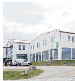
Am Standort in Reinsdorf stehen gut 100 Parkplätze zur Verfügung.
